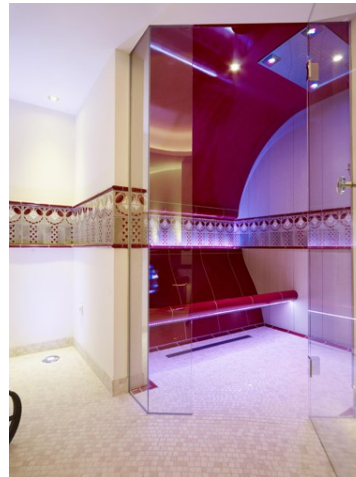
Raffinierte Decken- und Bankkonstruktionen sorgen für Komfort und Hygiene im Dampfbad. Foto: Hilpert GmbH & Co. KG
