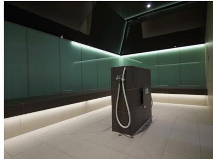
Bild 2: Langlebige Materialien in großen Formaten prägen das Design des neuen Dampfbads. Die handgefertigten keramischen Rinnen am Mittelelement fangen das Wasser im Boden auf.
