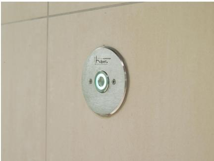
Bild 3: Über einen Taster lassen sich bei Bedarf Sprühnebelstöße abrufen.
