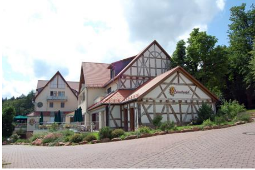
Anstelle eines Heubodens entstand der Anbau im Hotel Heimathenhof. Foto: Hilpert GmbH & Co. KG
