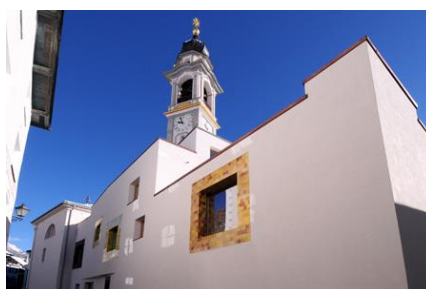
Handgefertigte Keramik rahmt die Fenster an der Fassade. Foto: Hilpert GmbH & Co. KG
