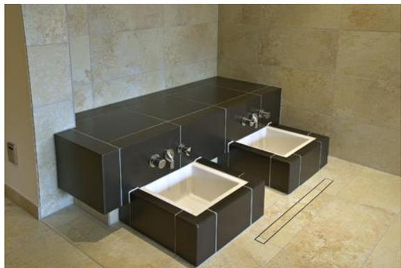
Handgefertigte Keramik in großen Formaten bekleidet die Wärmebank mit Fußbädern. Dank des geringen Fugenanteils schafft sie hygienische Oberflächen, die leicht sauber zu halten sind. Foto: Hilpert GmbH & Co. KG
