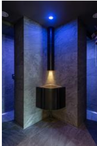
Bild 4: Die winklige Anordnung der Duschen hinter dem Eisbrunnen verhindert, dass Spritzwasser in den Raum entweicht. Foto: Hilpert GmbH & Co. KG
