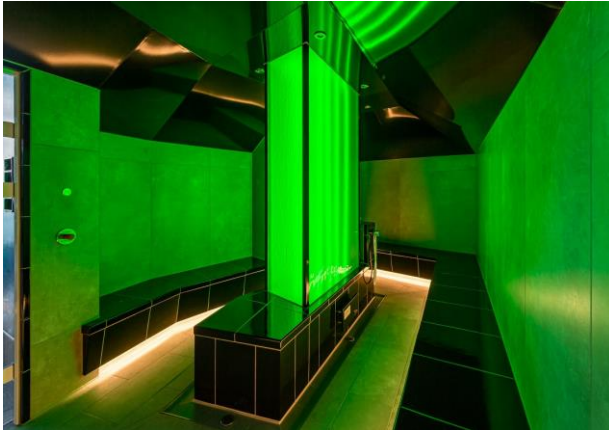
Bild 1: Ein raumhohes Mittelelement versorgt die Kabine mit Licht, Dampf und Wasser. Foto: Hilpert GmbH & Co. KG
