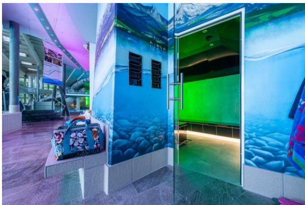
Bild 3: Im Eingangsbereich des Dampfbads sind die keramischen Brillenablagen in die Wand eingelassen. Foto: Hilpert GmbH & Co. KG
