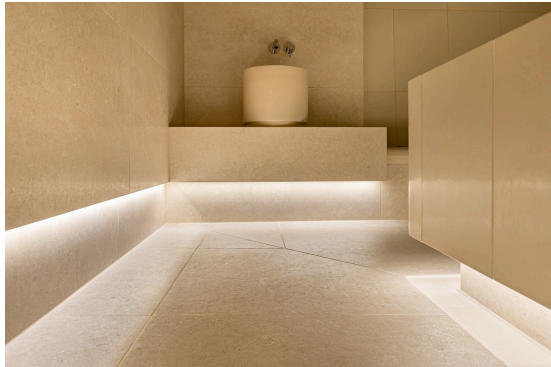
Bild 5 : Verdeckt liegende Lichtleisten unterstreichen die stimmungsvolle Atmosphäre. Die vom Nabelstein (rechts im Bild) herabrinneende Flüssigkeit fängt eine umlaufende Rinne am Boden auf. Foto: Hilpert GmbH & Co. KG
