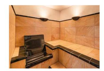
Die Wärmebank und die Wanne sind "aus einem Guss" gestaltet. So lassen sich unschöne Ecken vermeiden, die auch schwer sauber zu halten sind. Demselben Gedanken folgt die Abdeckung der Lehne, die gleichzeitig als Fensterbrett fungiert. Vor der Wärmebank wurde ein Fußbadebecken angeordnet, das harmonisch in die Gesamtgestaltung eingebunden ist.
