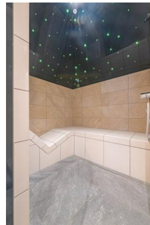
Bild 4: An der glatten Oberfläche der geneigten Decke des Tecaldariums® läuft Kondenswasser sauber zur Wand hin ab. Bild: Hilpert GmbH & Co. KG
