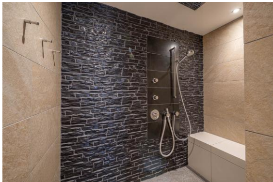
Bild 8: Von Hand gefertigte Keramik aus der Familienmanufaktur Hilpert setzt mit dunkler Glasur und lebendiger Struktur spannende Kontraste zur hellen Wandbekleidung aus Feinsteinzeug. An den Haken der beheizten Wand trocknen Handtücher schnell. Bild: Hilpert GmbH & Co. KG
